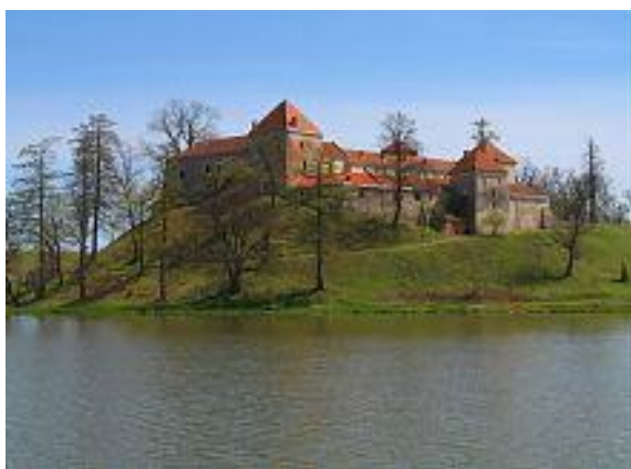
Рис. 1. Загальний вигляд Свірзького замку
